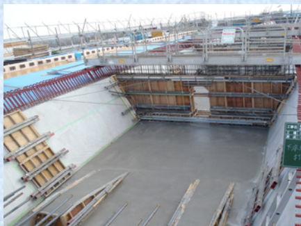
下床版間詰めコンクリート施工
