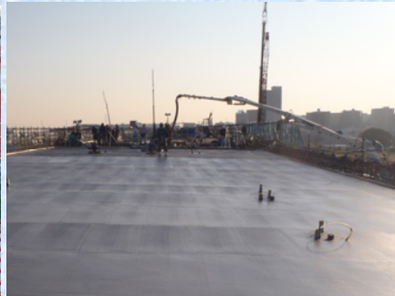
上床版コンクリート打設
