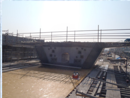
沓上ブロック施工完了
