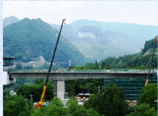
P1 張出し架設と A1 側径間支保工架設
