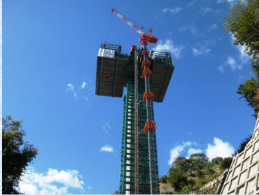
P2 架設作業車とタワークレーン
