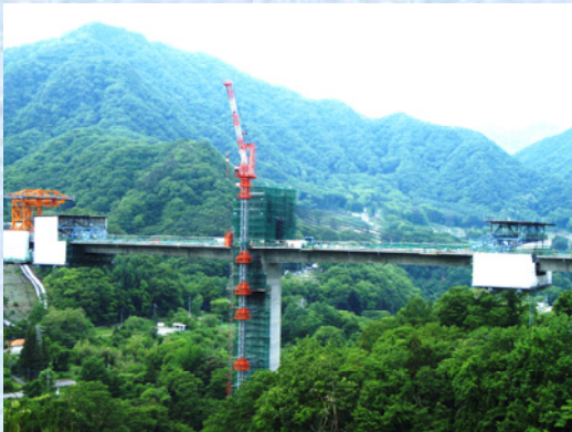
P2 張出し架設
