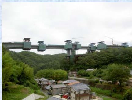
張出し架設状況
