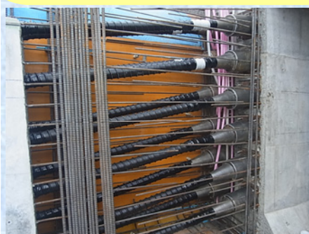
主方向 P C 鋼材配置
