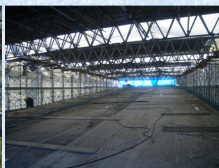
コンクリート養生
