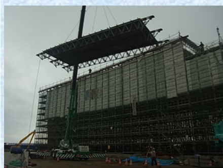
全天候養生設備組立
