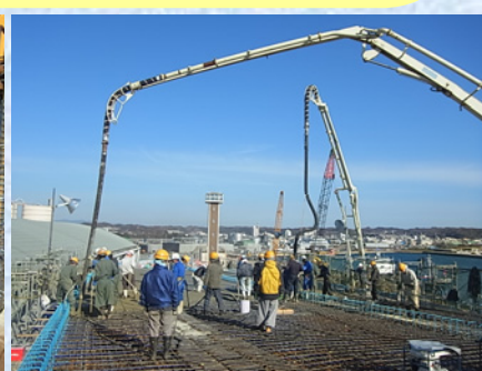
コンクリート打設状況
