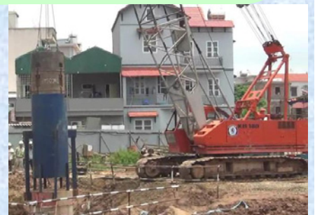
杭の動的載荷試験
