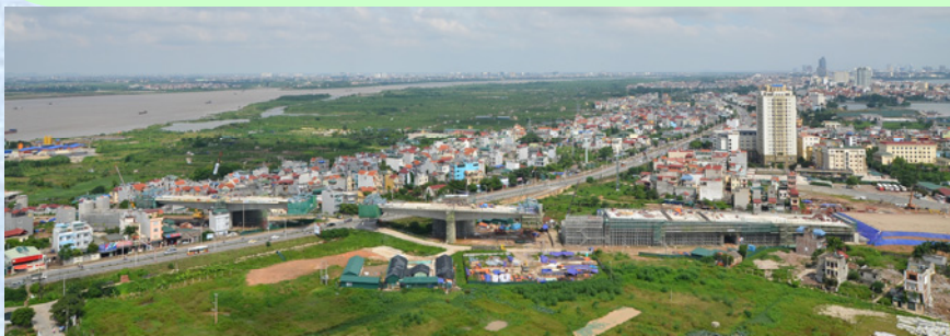
施工全景写真
