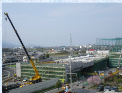
P2-P5 施工状況
