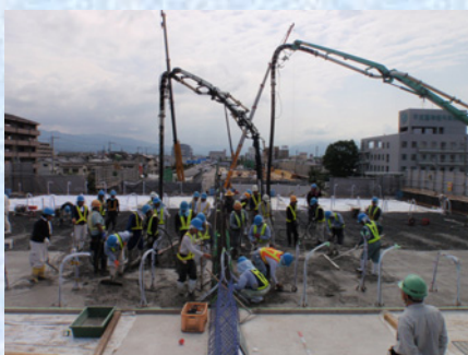
P1-P2 コンクリート打設
