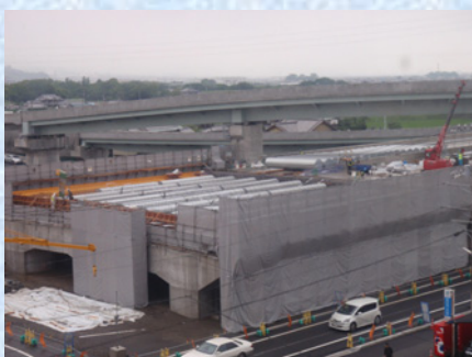
P1-P2 円筒型枠配置
