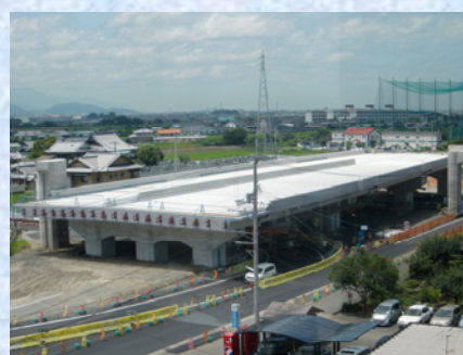
P2-P5 施工完了
