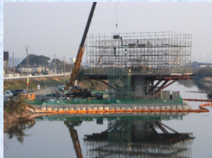
河川築島上の P1 柱頭部施工
