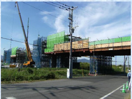
P3-P4 鉄道・道路交差部 支保工架設
