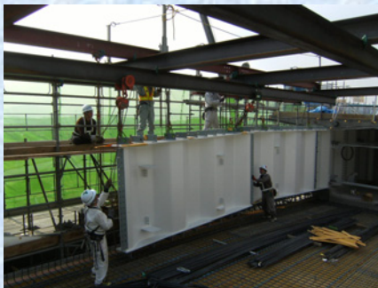
P3 支保工部波形鋼板架設
