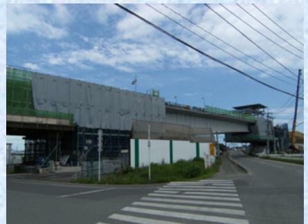
P4 左支保工架設と右張出し架設
