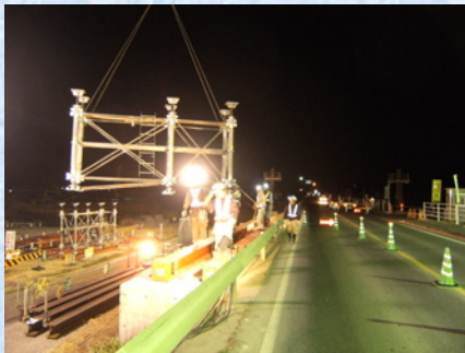
A1 側径間支保工組立夜間作業
