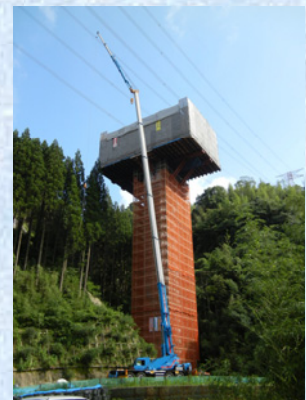
送電線との近接作業
