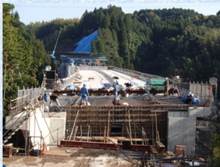
側径間吊支保工部
