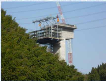
架設作業車組立
