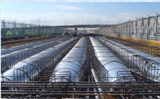
円筒型枠設置状況
