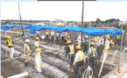
コンクリート打設状況
