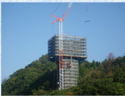
P2柱頭部施工
