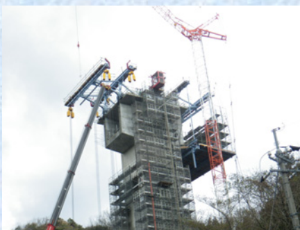
P1架設作業車組立
