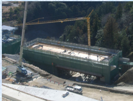
側径間固定支保工施工
