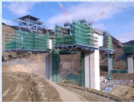
架設作業車組立
