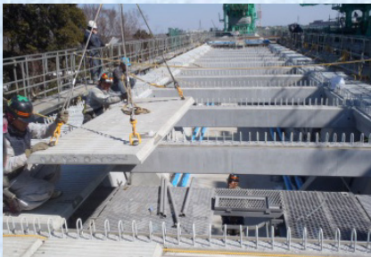
PC板敷設状況
