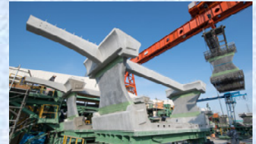
セグメントの製作状況
