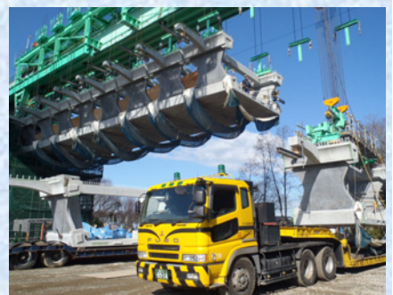
セグメント架設状況
