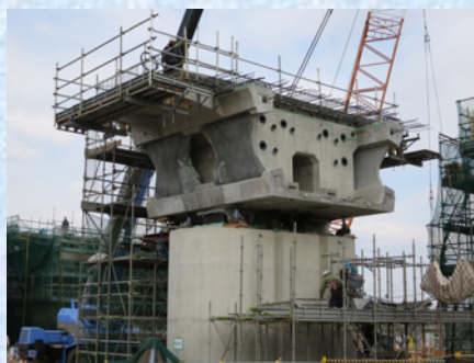
柱頭部の完成
