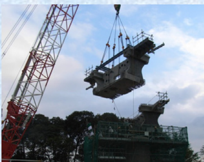
柱頭部セグメントの架設状況
