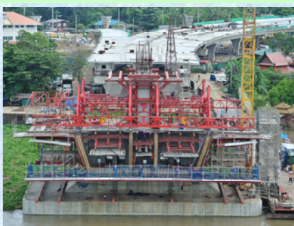
架設作業車全景
