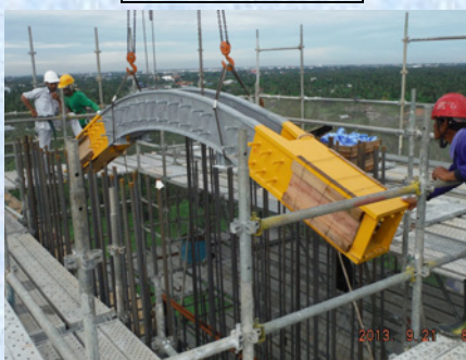
斜材定着型サドルの架設
