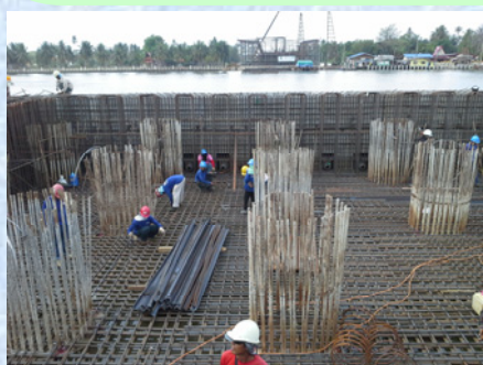
フーチング施工
