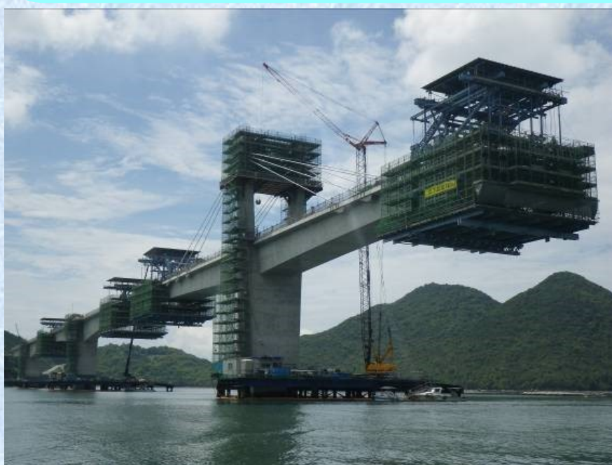
大型架設作業車施工状況
