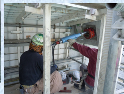
斜材緊張状況
