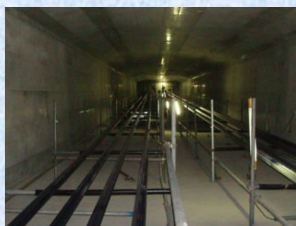
外ケーブル緊張状況
