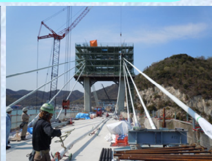
斜材架設状況
