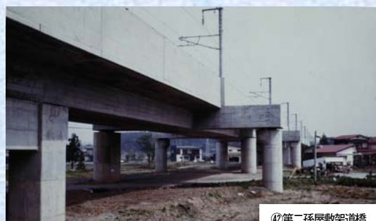
㉗第二孫屋敷架道橋
