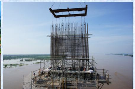
主塔鉄筋プレファブ架設
