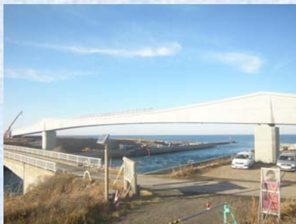
張出し架設部施工完了
