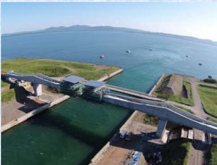
架設作業車架設状況
