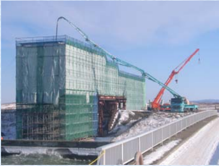
コンクリート打設状況
