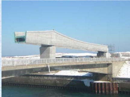
固定支保工部施工完了
