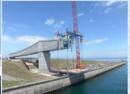
架設作業車組立状況
