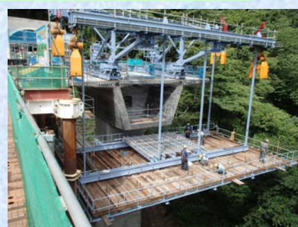
架設作業車組立
