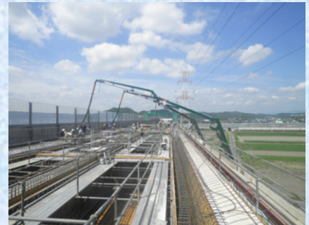
コンクリート打設状況
