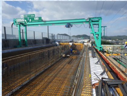
門型クレーン使用
