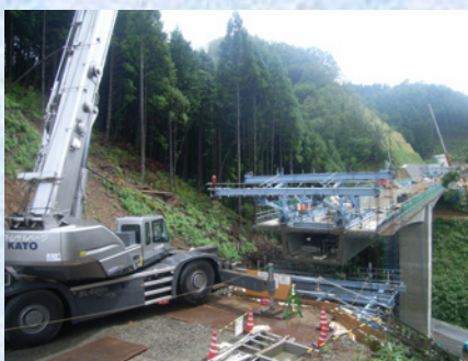
架設作業車解体
