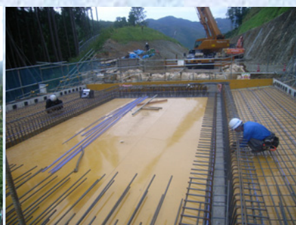
側径間支保工施工
