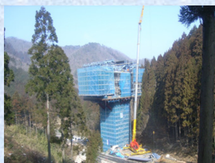
架設作業車組立
