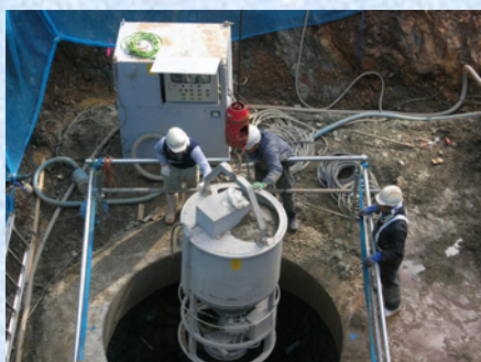
深礎工遠心力吹付け
