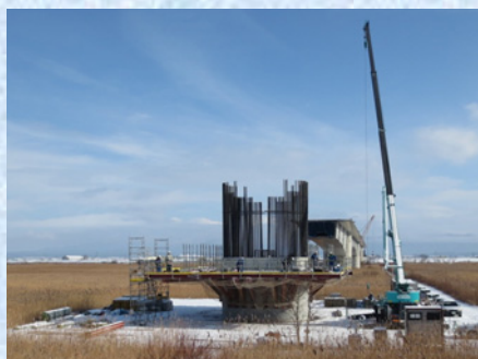
柱頭部 (P5) 施工
