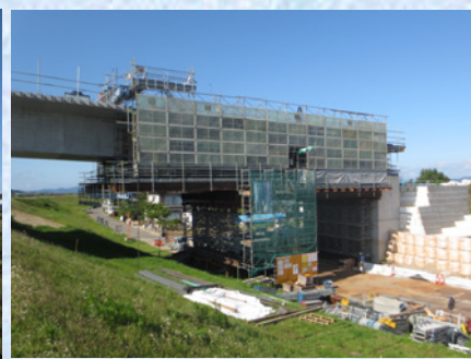
側径間支保工部 (A1) 施工
