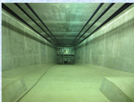
外ケーブル施工
