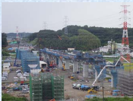
施工状況全景
