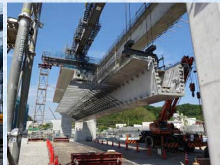
U桁吊上げ架設
