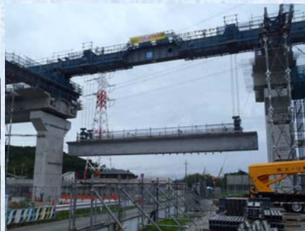
U桁吊上げ架設
