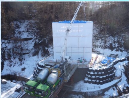
橋台コンクリート打設
