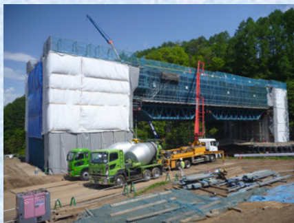
上床版コンクリート打設
