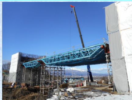
上部工支保工トラス梁組立
