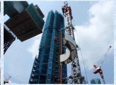
SPER 架設状況
