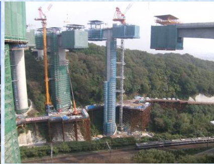
鉄道上張出し架設(PA3)
