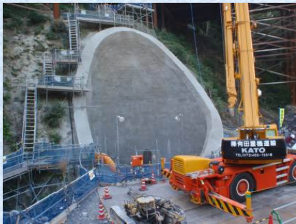
竹割り土留め工法
