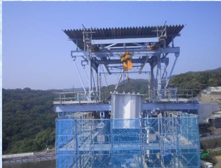
波形鋼板架設状況
