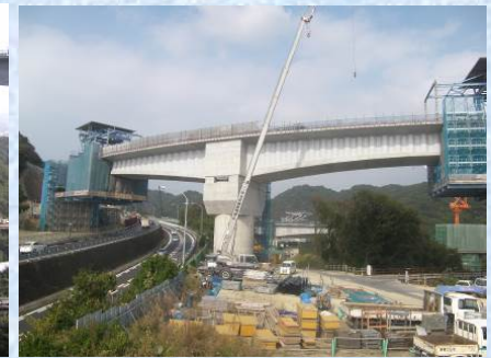
高速道路上張出し架設(PA5)
