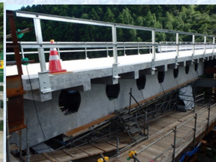
架設完了状況
