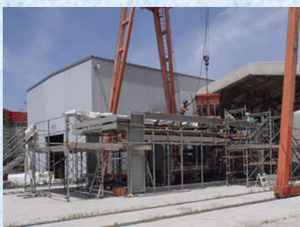
セグメント製作状況
