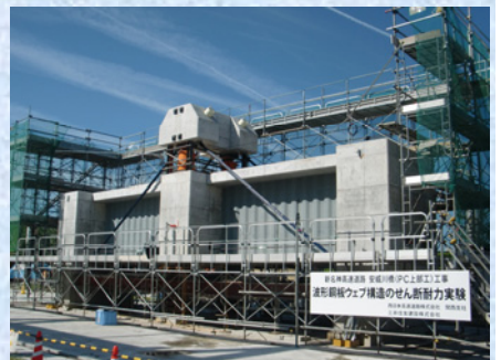
波形鋼板ウェブせん断耐力実験
