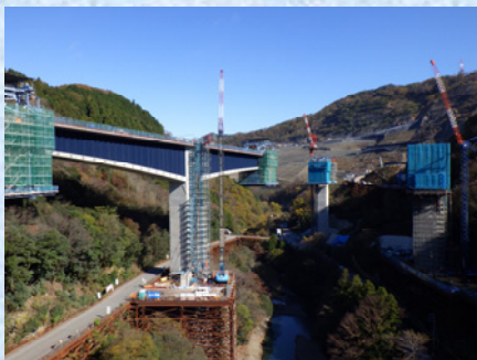
上り線 P6 張出し架設状況
