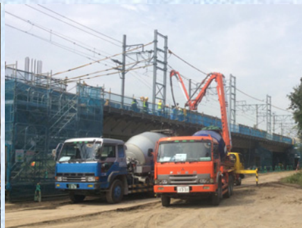
床版コンクリート打設状況
