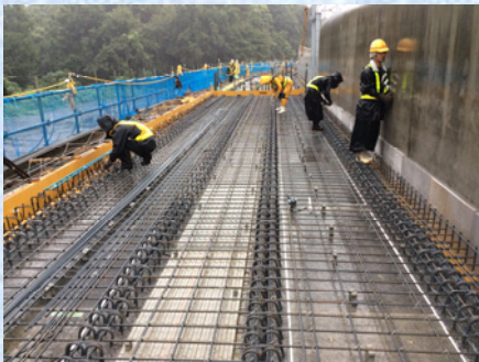
床版施工状況
