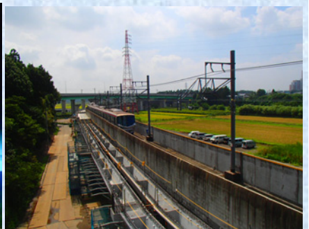
桁架設完了
