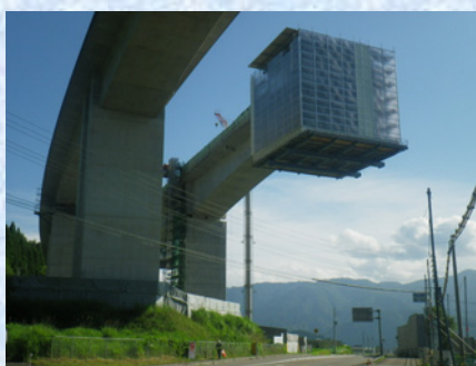
張出し架設県道上空防護
