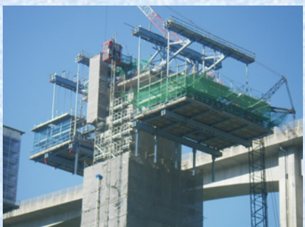
架設作業車組立
