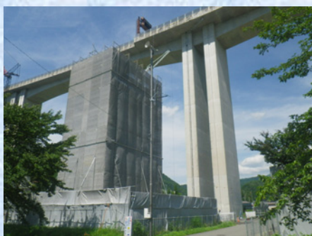
下部工施工・Ⅰ期線二枚壁橋脚
