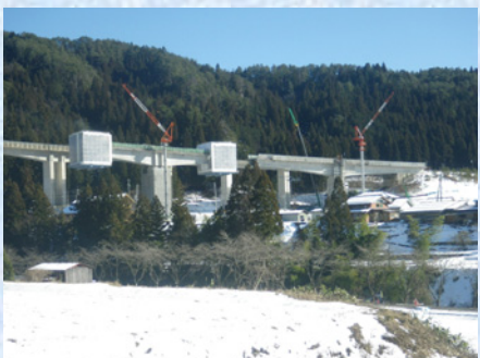
冬季張出し架設
