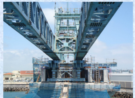
P3-P4 径間 主桁架設完了
