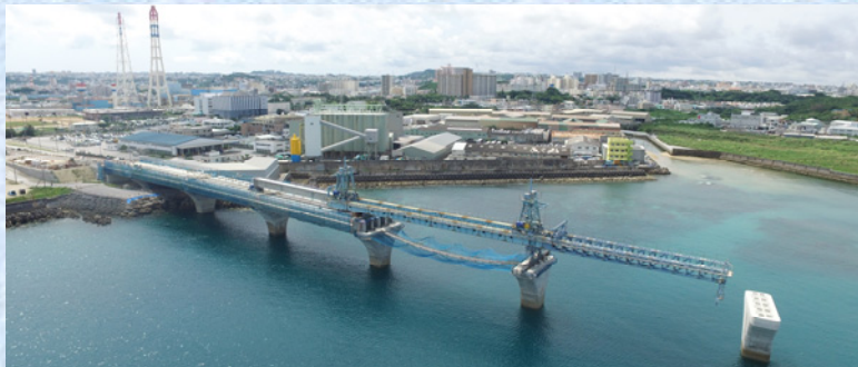
主桁架設状況（全景）
