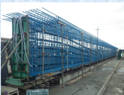
主桁製作（鉄骨鉄筋・PEシース）
