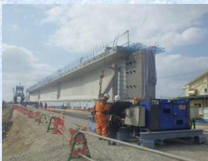
主桁引き出し（自走台車）
