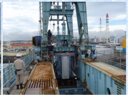
主桁架設（主桁重量：158t）
