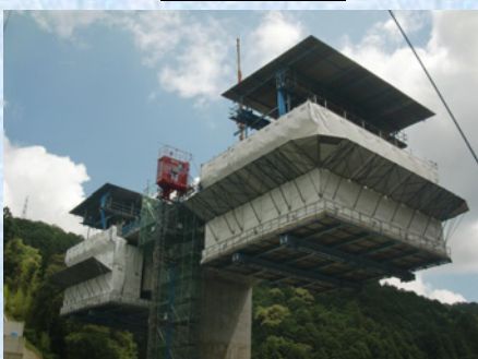
張出し架設状況
