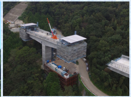
張出し架設状況
