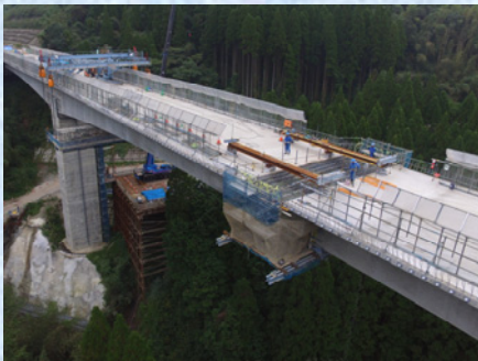
中央閉合施工状況
