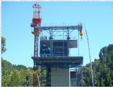
架設作業車組立状況
