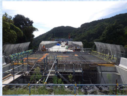
側径間施工状況
