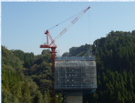
柱頭部施工状況
