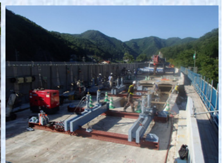
既設床版剥離状況
