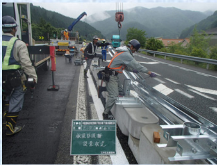
迂回路設置状況
