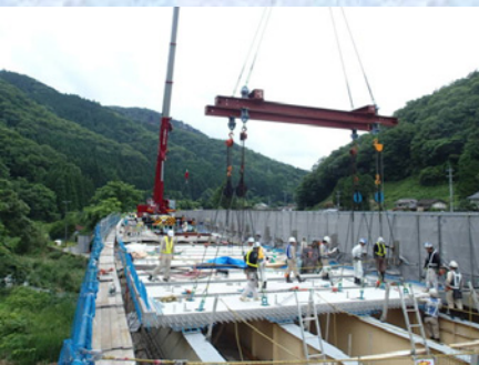
プレキャストPC床版架設状況
