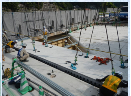
延長床版架設状況
