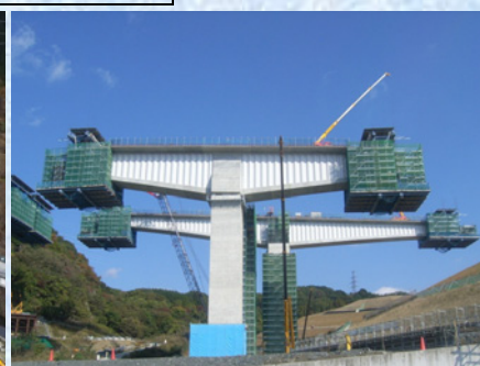
波形鋼板部の張出し架設
