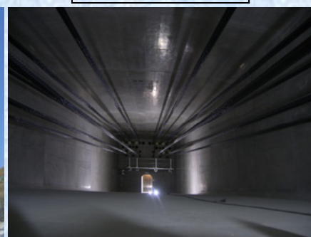
外ケーブル配置状況
