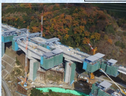
分岐部の張出し架設
