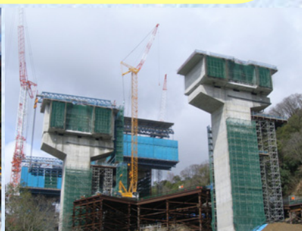
3室箱桁の大断面
