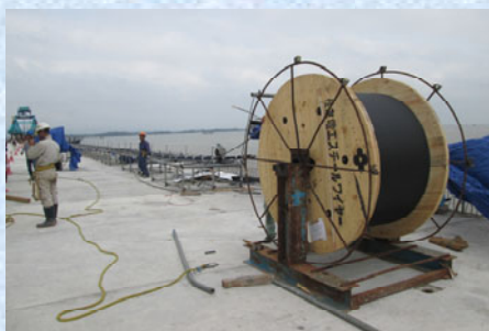
橋面上外ケーブル
