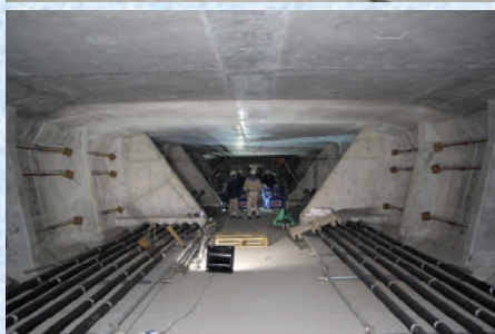
桁内外ケーブル配置
