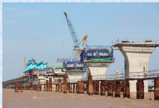
海上部支点セグメント先行架設
