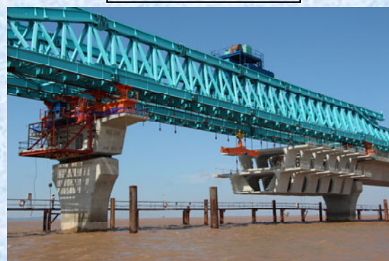
海上部セグメント架設
