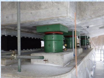
仮固定鉛直ジャッキ使用
