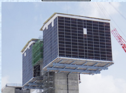
架設作業車積雪期養生
