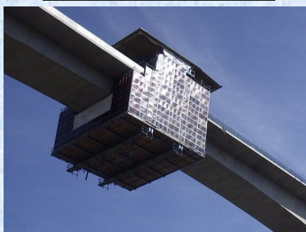
中央連結部施工
