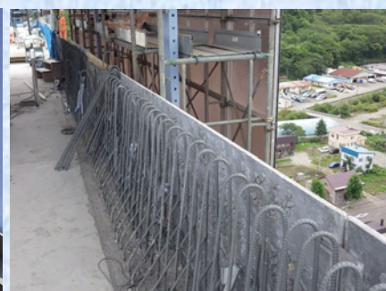
壁高欄埋設型枠
