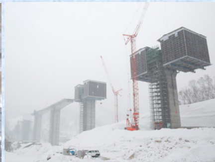
積雪期張出し架設
