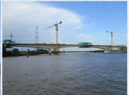
張出し架設状況
