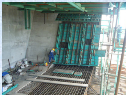
内部側型枠と窓構造
