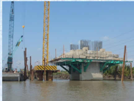
柱頭部支保工載荷試験
