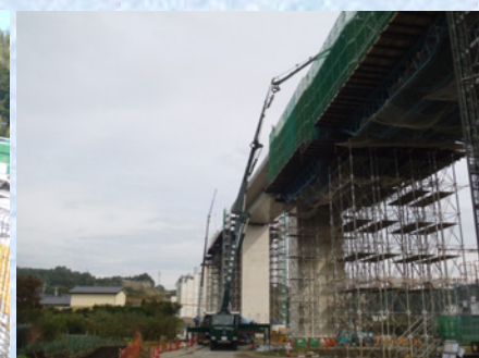
コンクリート打設状況
