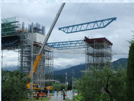
トラス梁架設状況
