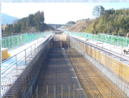
鉄筋 PC 組立状況
