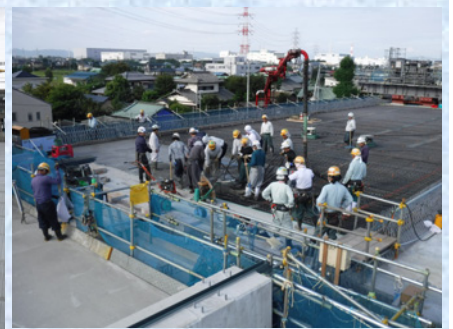
床版コンクリート打設
