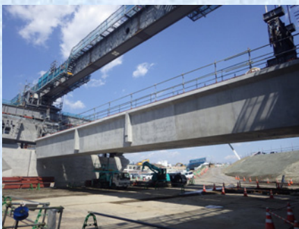
U桁リフティング架設
