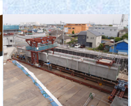
U桁セグメント接合
