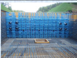
エポキシ被覆鉄筋 (桁端部)
