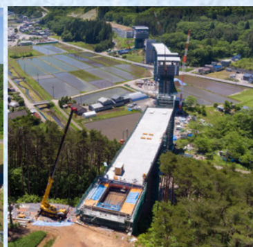
側径間閉合部施工
