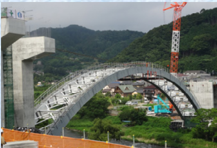
ロアリング架設完了
