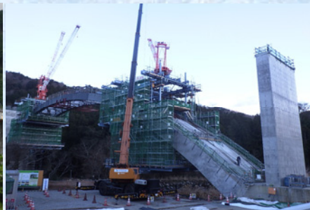
アーチリブ巻立施工状況
