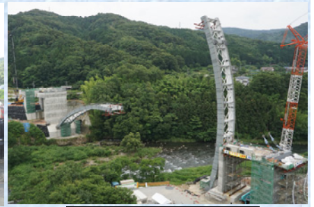
ロアリング架設状況
