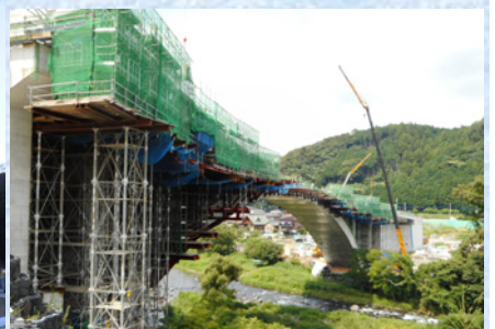
補剛桁施工状況
