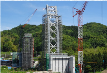
メラン材組立状況
