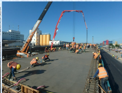
箱桁橋コンクリート打設
