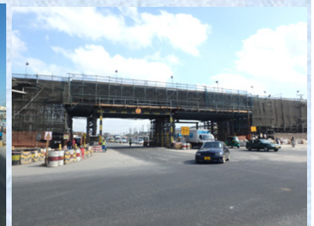
箱桁橋交差点内支柱式支保工
