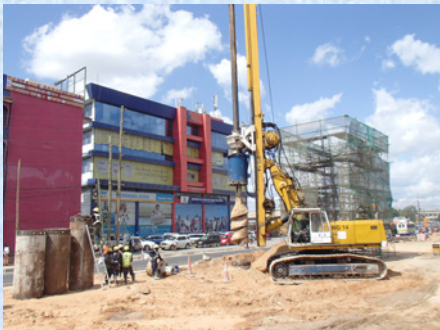
場所打ち杭施工状況
