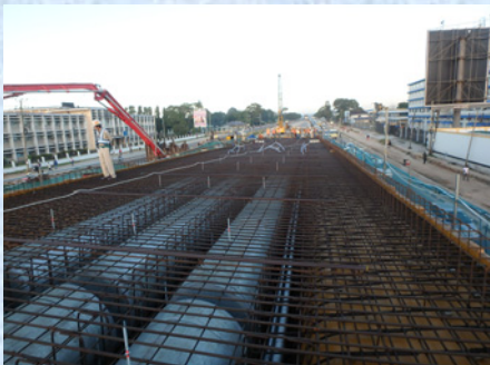
中空床版橋施工状況
