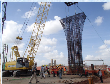
橋脚プレファブ鉄筋架設状況
