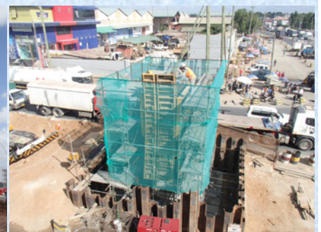
橋脚鋼製システム型枠
