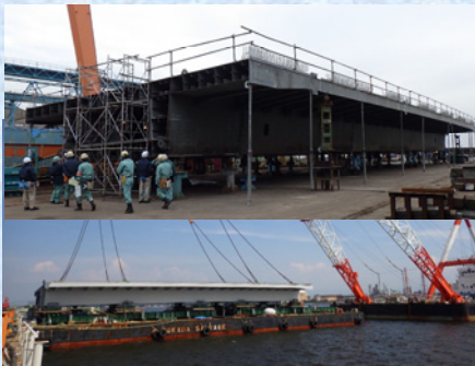
鋼桁製作と積み込み状況
