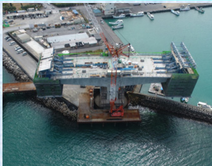
P5 張出し架設状況
