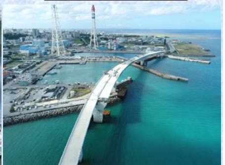
全橋架設状況
