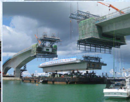
鋼桁部一括吊上げ架設
