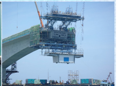
P6 側接合桁架設状況
