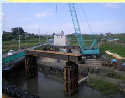
渡河部支保工組立状況
