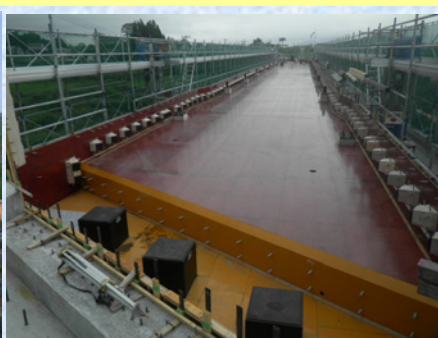
補剛桁底版型枠
