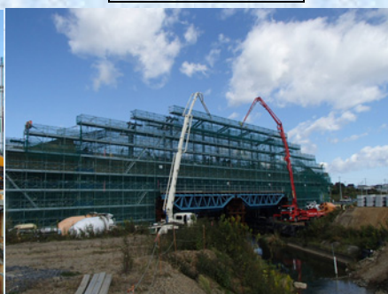
補剛桁コンクリート打設
