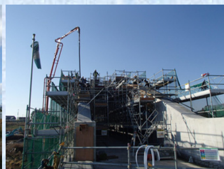
アーチリブコンクリート打設
