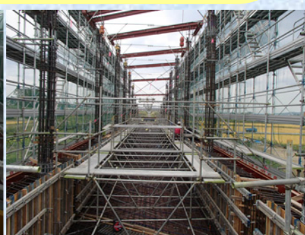
補剛桁打設前(1リフト)
