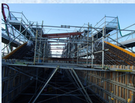
補剛桁打設前(2リフト)
