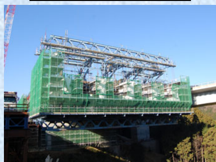
張出し架設状況（3 径間）
