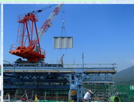
波形鋼板ウェブ架設状況（7 径間）
