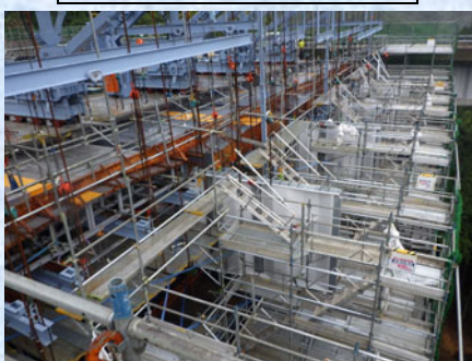
波形鋼板ウェブ架設状況（3 径間）
