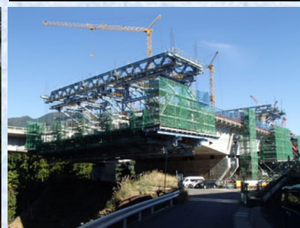
超低床架設作業車（3 径間）
