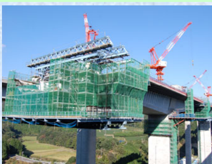
張出し架設状況（7 径間）
