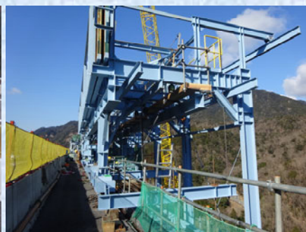
床版施工作業車（錐ヶ瀧橋）
