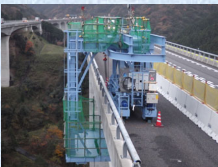
壁高欄撤去作業車（錐ヶ瀧橋）
