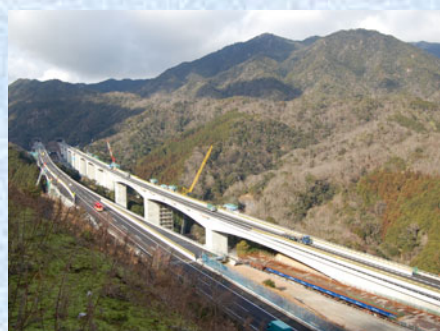
拡幅工事全景（錐ヶ瀧橋）
