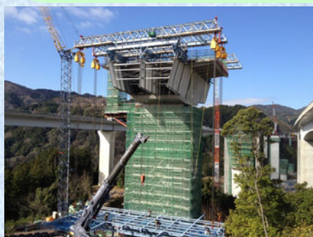
架設作業車組立（7 径間）
