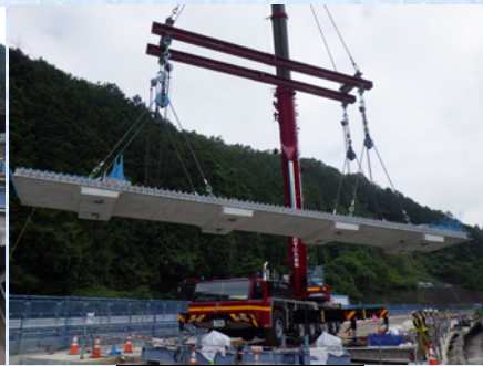
標準版架設状況
