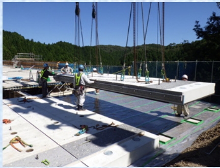
(A1側) 底版架設状況
