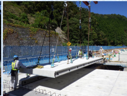
(A1側) 延長床版架設状況
