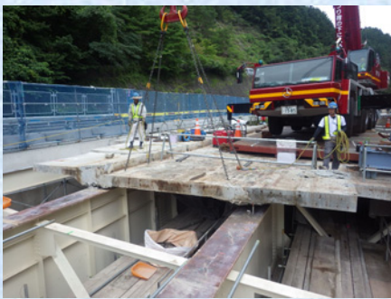
既設床版撤去状況
