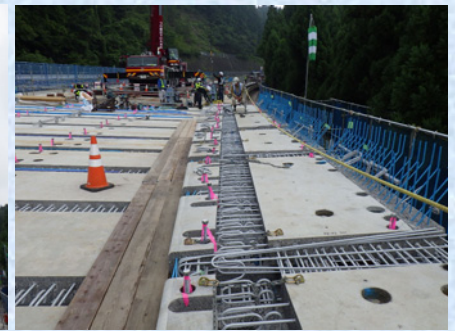
張出し床版架設状況
