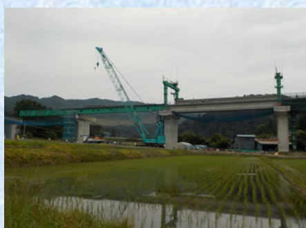
架設桁・揚重機移動
