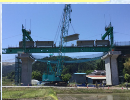
セグメント桁架設
