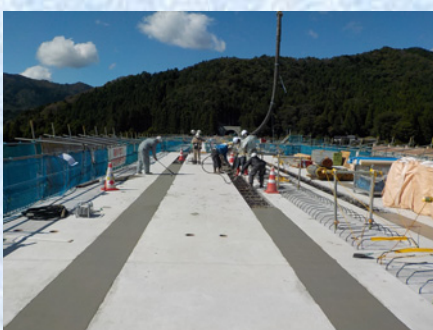
横組・間詰打設状況
