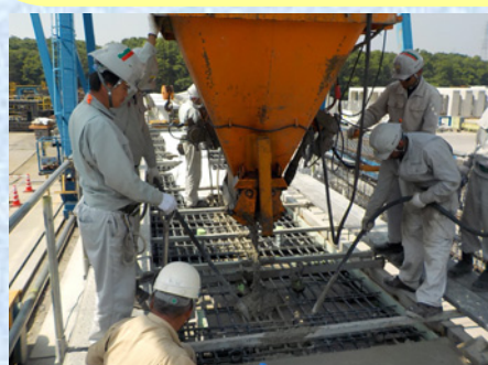
主桁(高流動)コンクリート打設
