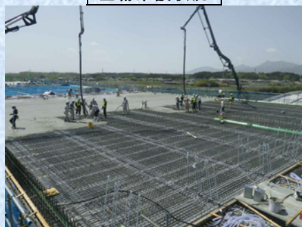
床版コンクリート打設状況
