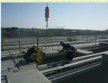
P C板架設状況
