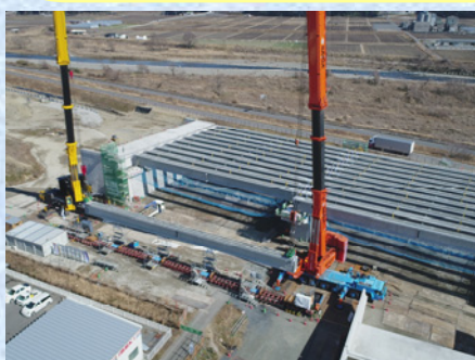
主桁架設状況
