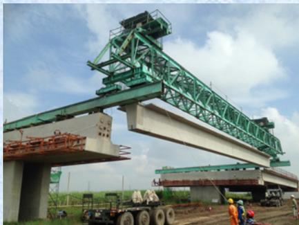
アプローチ橋スーパーT桁架設状況
