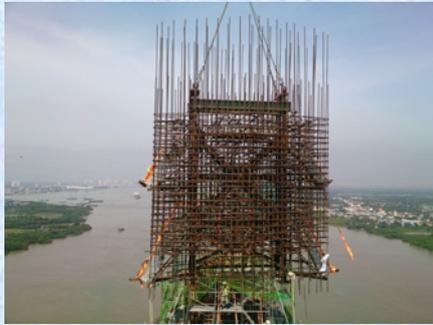
主塔鉄筋・鋼製サドル架設状況
