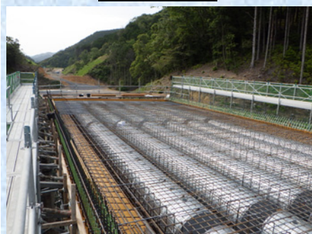
円筒型枠組立状況
