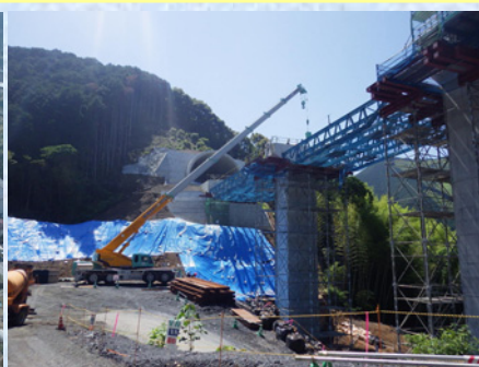
支保工組立状況
