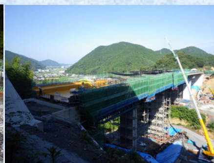
施工中全景（地上）
