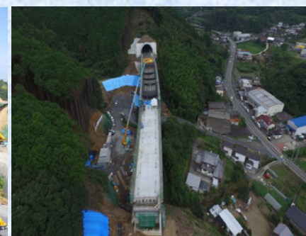
施工中全景（空撮）
