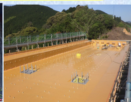
型枠組立状況
