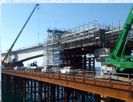
側径間支保工部施工
