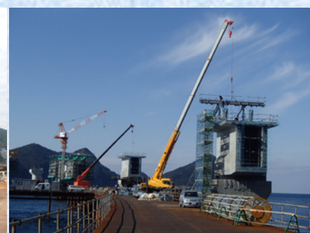
架設作業車組立
