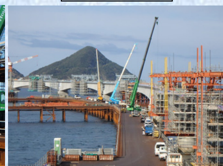
隣接工区同時張出し架設状況
